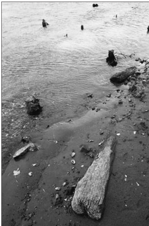
17. kép: A partközeli I. csoporthoz tartozó cölöpjárom maradványai, melyek az 1562-ben vert első hídhoz tartoznak (fotó: Ratkai Barnabás).
